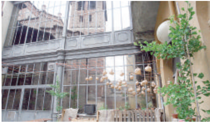
I lavori per l'allestimento della «Green zone»
