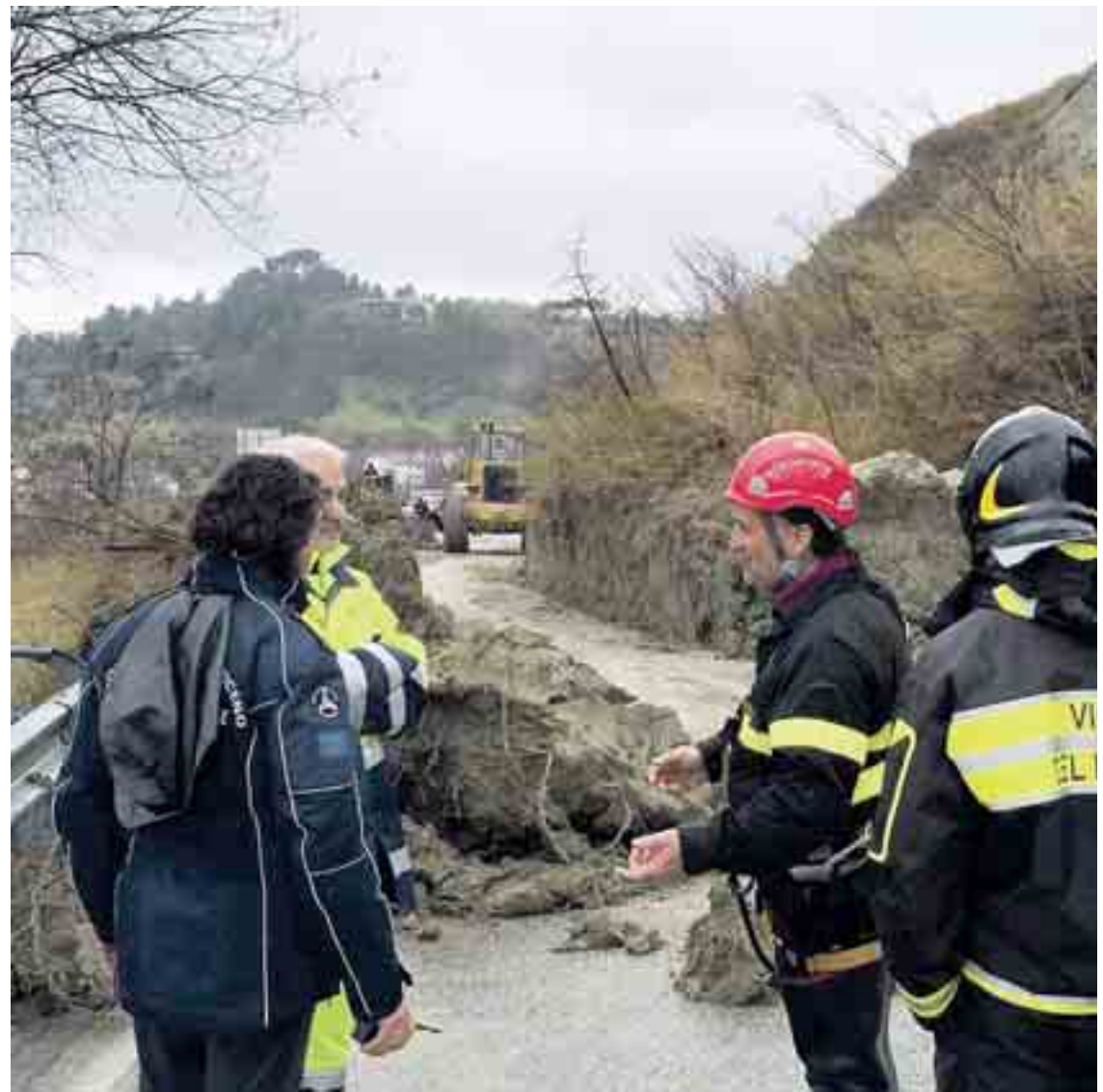
La gigantesca frana che ha ostruito la Salaria all'altezza di Brecciarolo (Fotoservizio FOTOSPOT)
