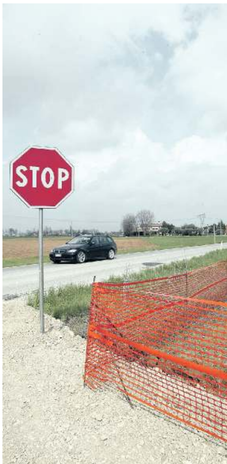
VEDELAGO Il cantiere dei lavori per la Pedemontana
