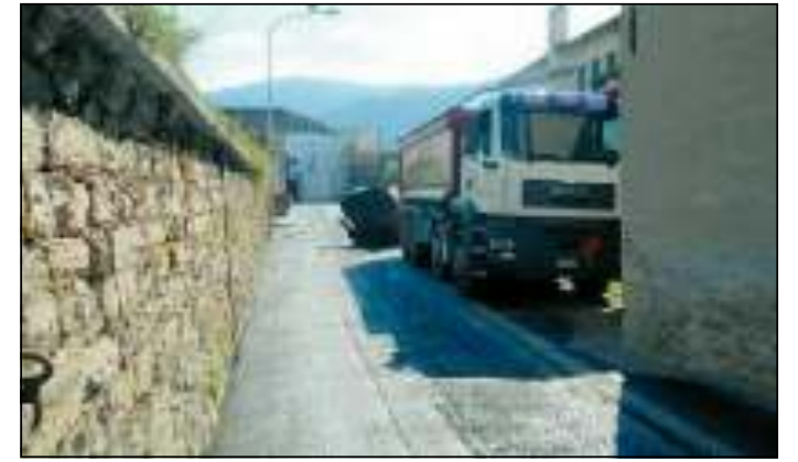
CANTIERE Maestranze al lavoro nell'area dietro il municipio
