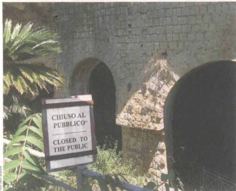
Inaccessibili da anni, le Cento Camerelle di Bacoli, cisterna romana del I secolo, sono qui metafora di un patrimonio in crisi poiché' privo di vocazione sodale
