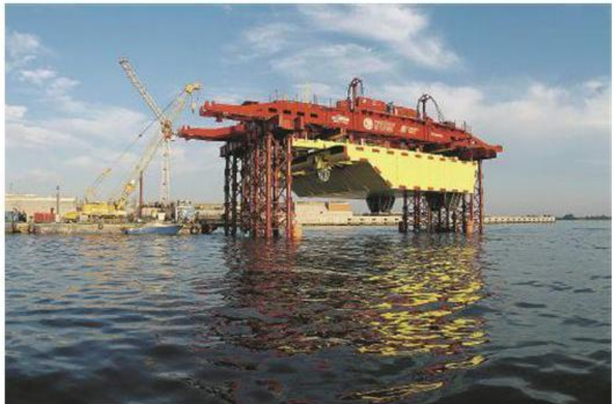
Un'immagine dell'installazione della prima paratoia del Mose Ansa
