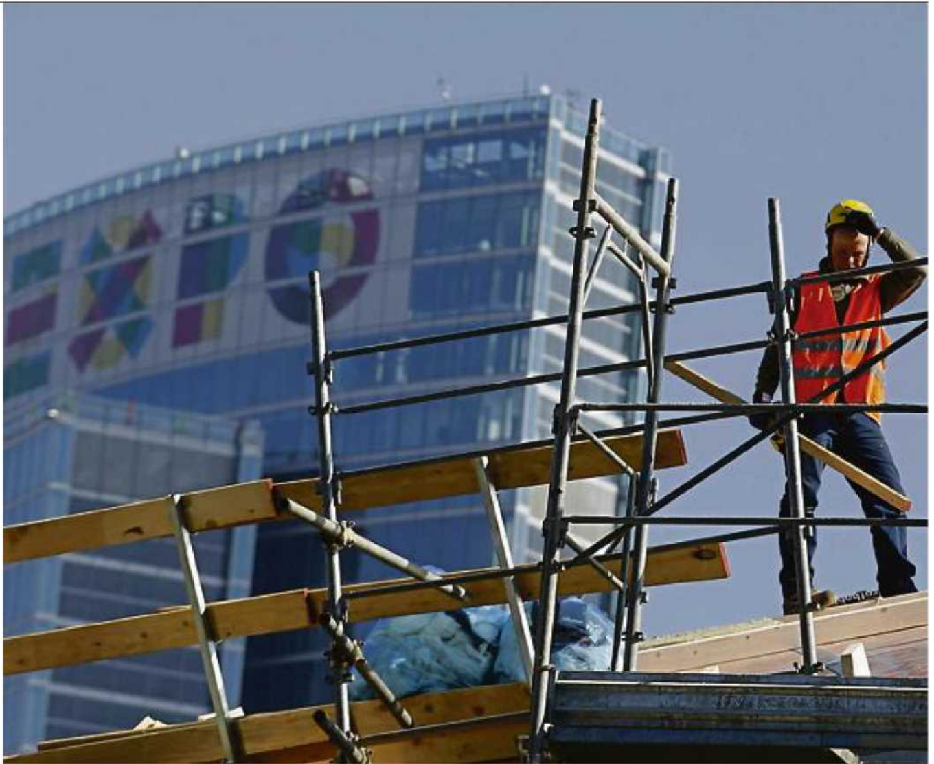
Les quelque 6.000 ouvriers s'emploient, jour et nuit, à rattraper les retards du chantier, après les scandales de l'année dernière. Photo Luca Bruno/AP/Sipa
