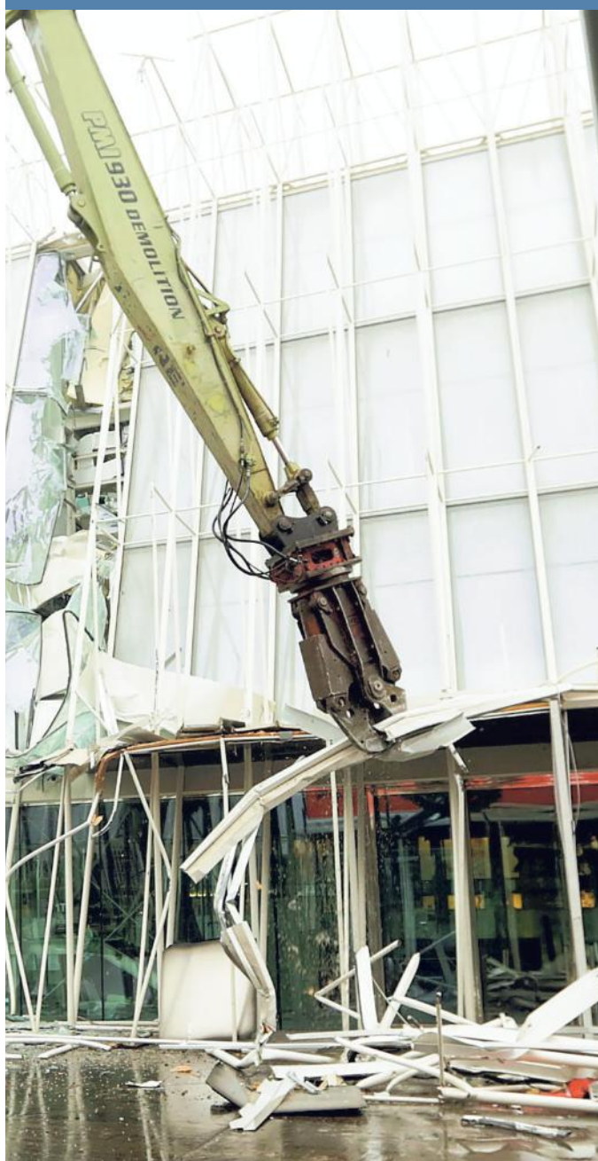
I lavori di demolizione degli Expo Gate davanti al Castello Sforzesco
