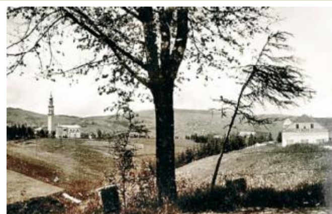
L'edificio Lazzaretto-Romita dove venne alloggiata parte degli ebrei
