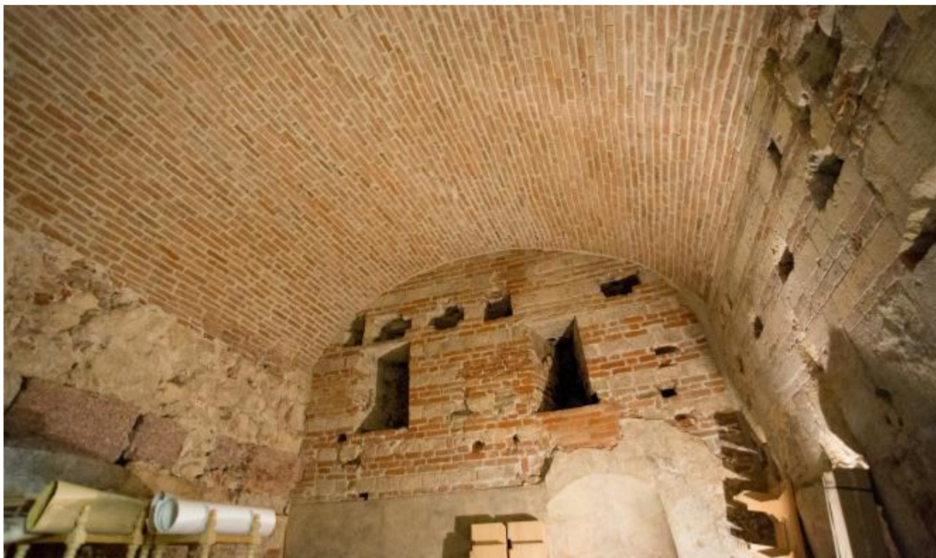
La torre romana e il muro di Gallieno-Teodorico con la copertura medievale
